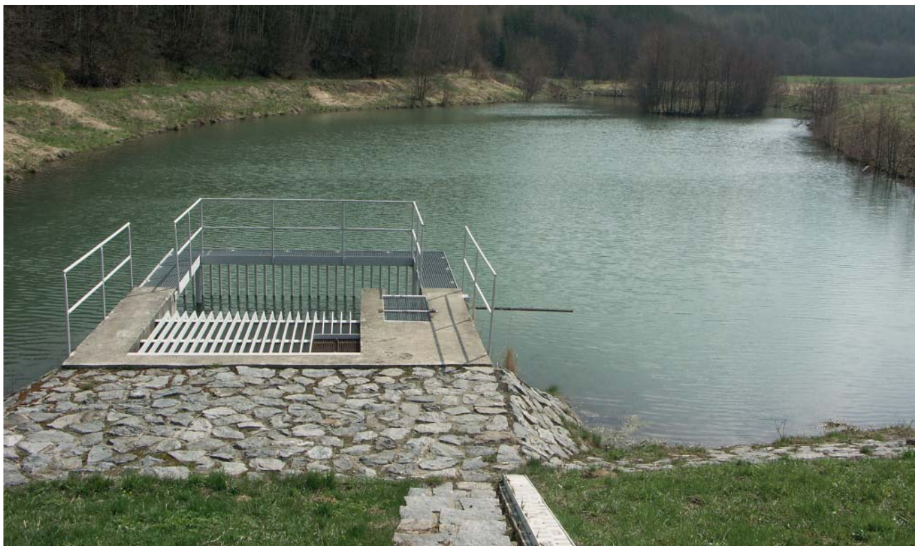
Udržovaný sdružený objekt malé vodní nádrže
