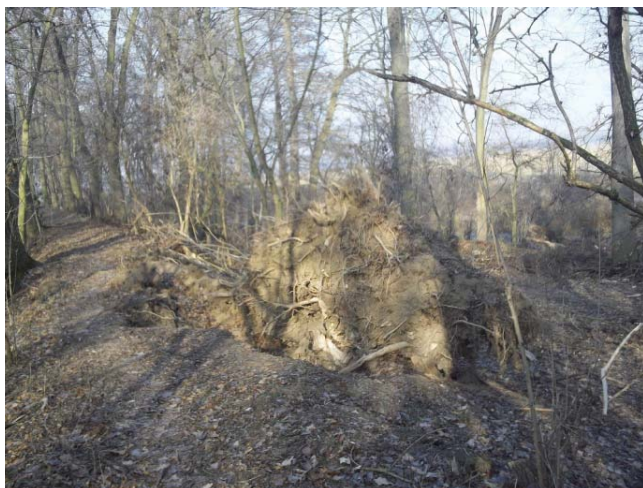
Nebezpečný vývrat stromu na hrázi rybníka
